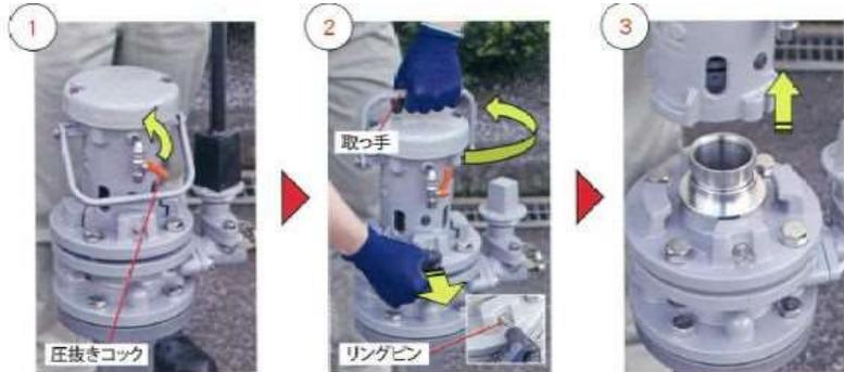
水道用空気弁-急速 JWWA B-137 スーパーエア-
